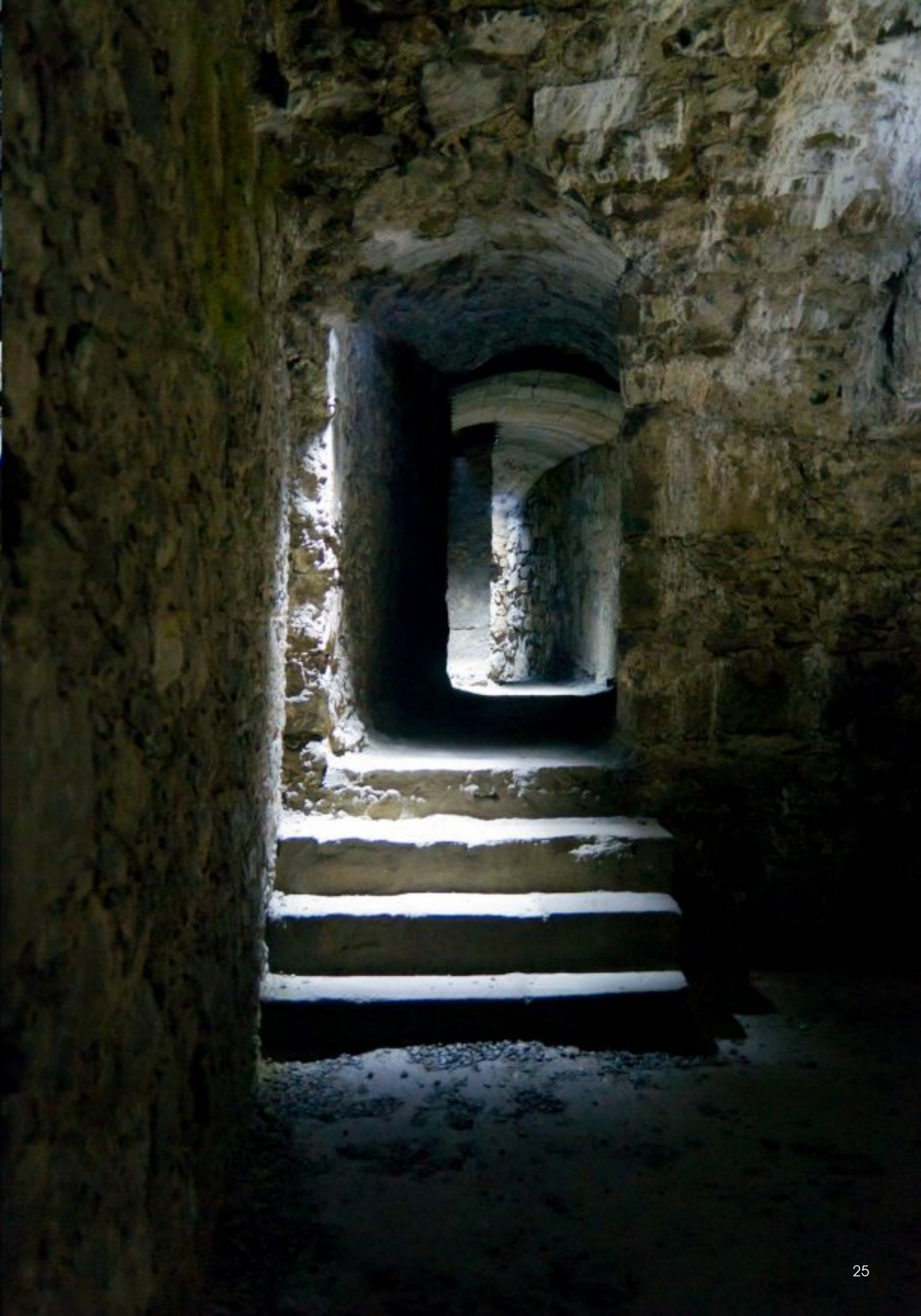
Einige Kasematten wurden auch nach der Schlosszerstörung noch zu Kühlzwecken genutzt. An den dafür geschaffenen Zugängen finden sich Ausmauerungen aus Backstein. Diese haben aber mit den ursprünglichen Kasematten nichts zu tun.
